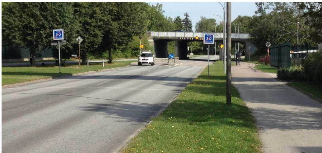
Figur 10. Tunavägen österut mot passagen under E22.
