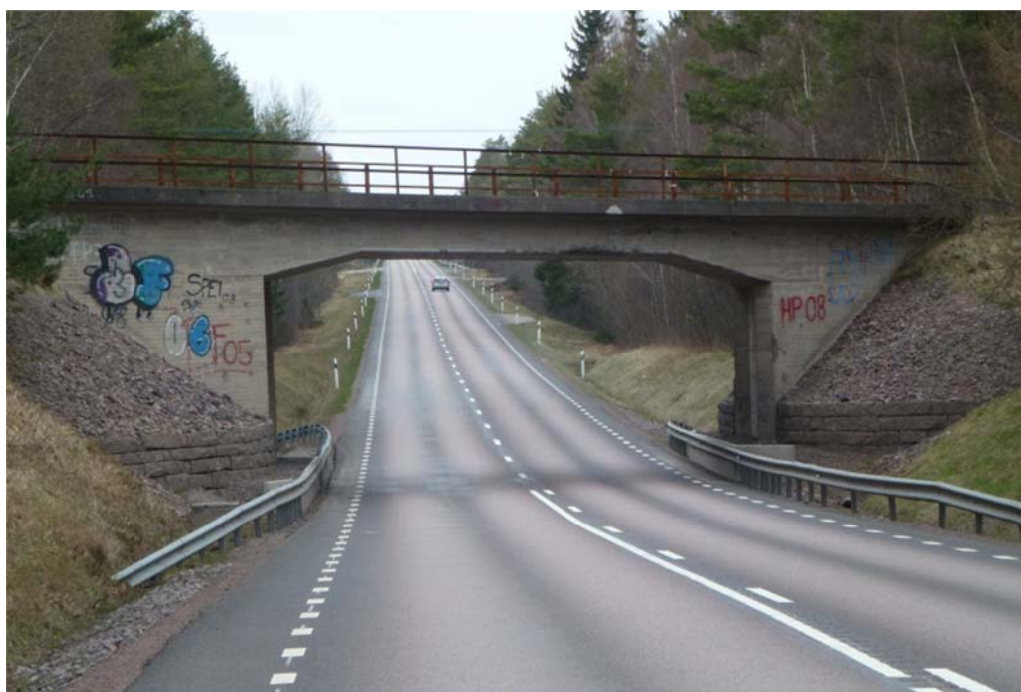
Figur 4 Bronn 8-159-1 Järnvägsbro över allmän väg vid Ödhult. Byggår 1961. Spännvidd 12,2 meter.
