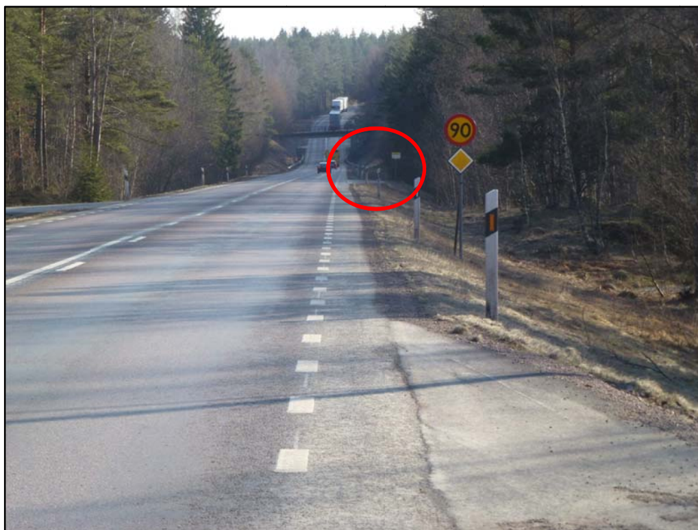
Figur 6 Busshållplatsen norr om Ödhult i södergående riktning ligger inte i anslutning till en anslutande väg, vilket medför att bussresenärerna måste gå i vägrenen längs med väg 23.
