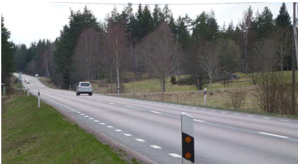
Figur 11: Omgivningarna kring väg 23 vid Lillråsa.
