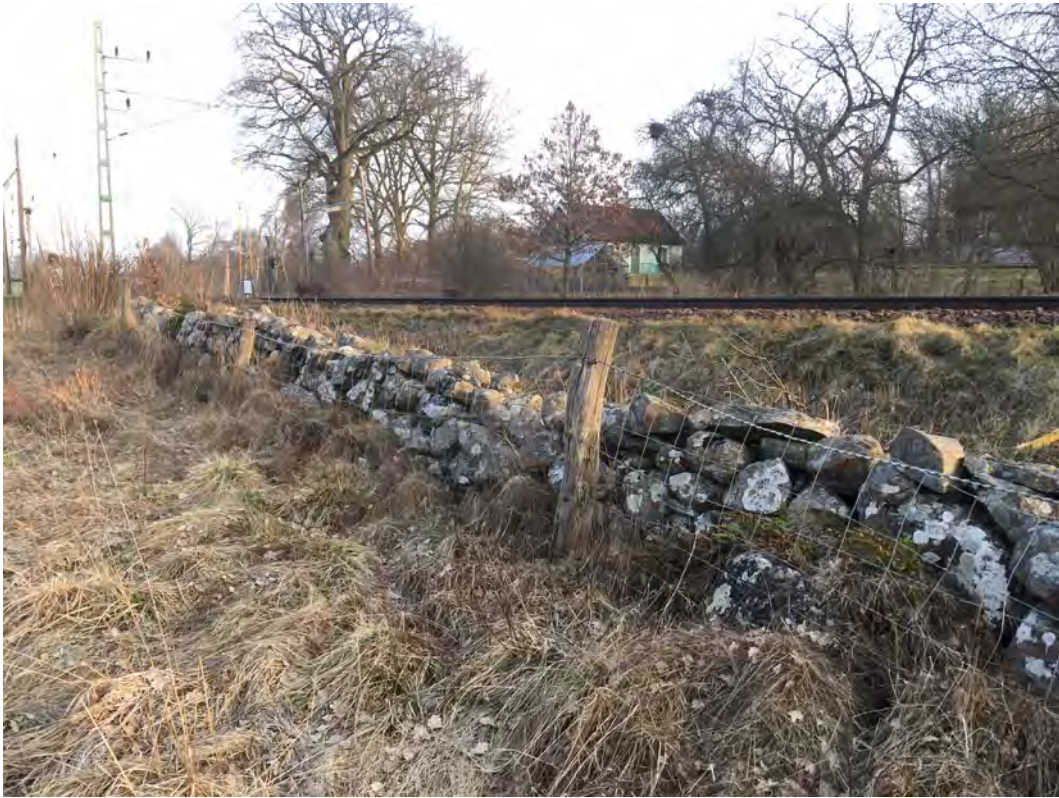
Stenmuren på norra sidan av järnvägen.
