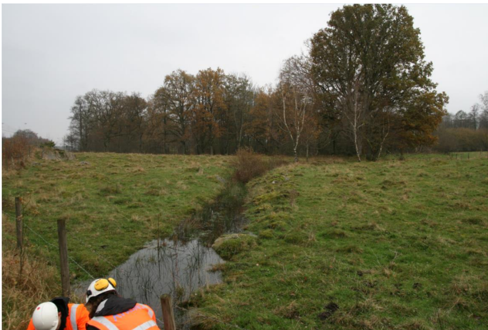
Figur 2. Bild på dike som går bakom teknikhus vid ca km 5+840. Från platsbesök 2017-11-09.
