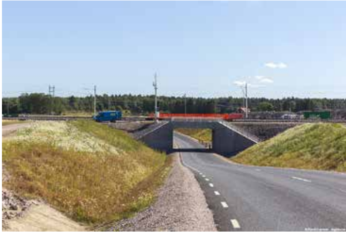
Figur 19 Exempel på referensbro för utformningen av ny rambro för passage under järnvägen i Attarp
