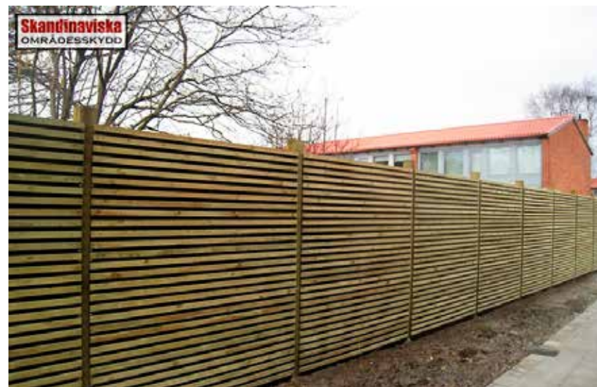
Figur 29 Exempel på den typ av bullerplank som föreslås i Attarp, liggande panel.
