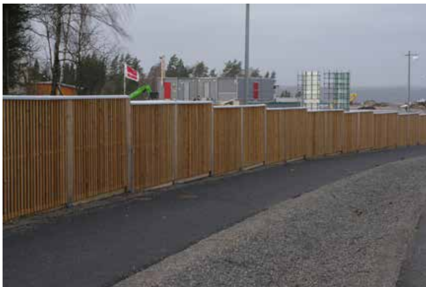
Figur 28 Exempel på den typ av bullerplank som föreslås i Attarp, stående panel.
