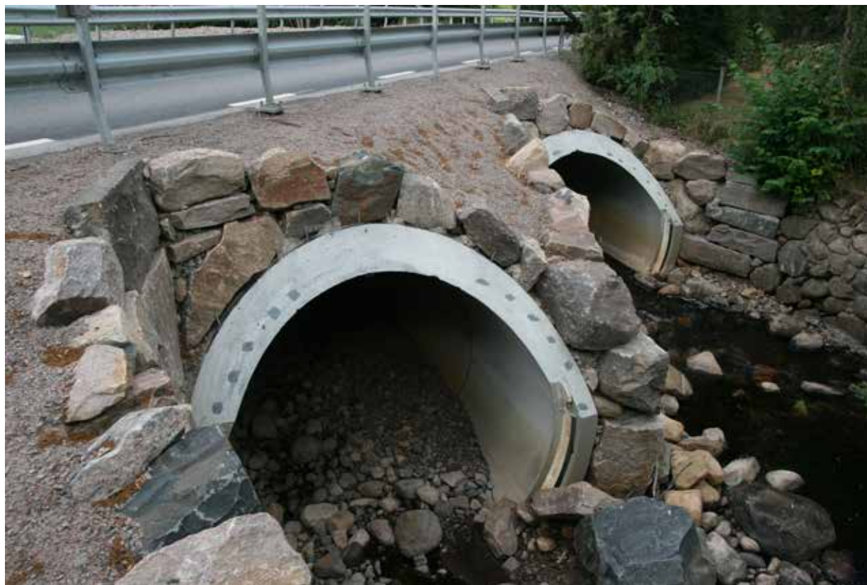
Figur 25 Exempel på utformning av trumma med snedkapade trumögon samt erosionsskydd.
