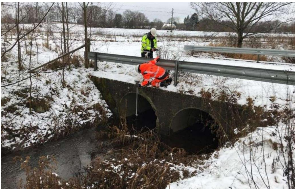
Figur 17. Plats för befintlig passage över Fjärlövsån, uppströms nya trummor under väg 2023. Foto: Tyréns.
