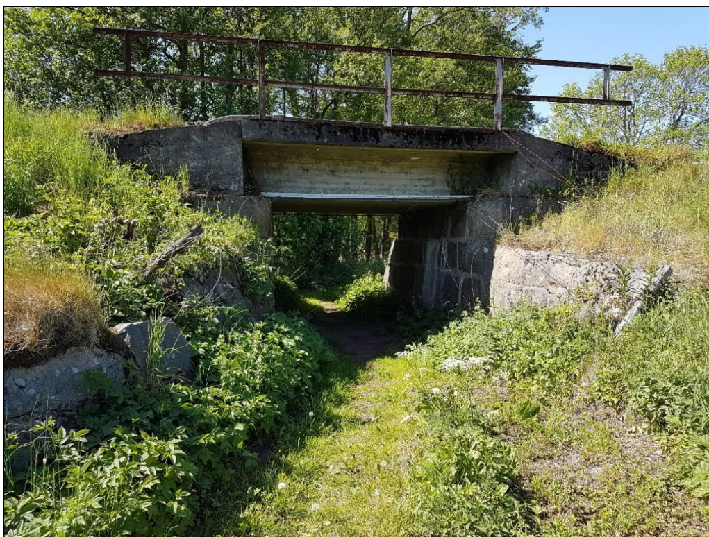
Figur 3. Plats för planerad omledning av Fjärlövsån går under en järnvägsbro som använts som kreaturport. Ursprungligen har bron gått över just Fjärlövsån innan den leddes om till sin nuvarande sträckning. Foto: Tyréns.
