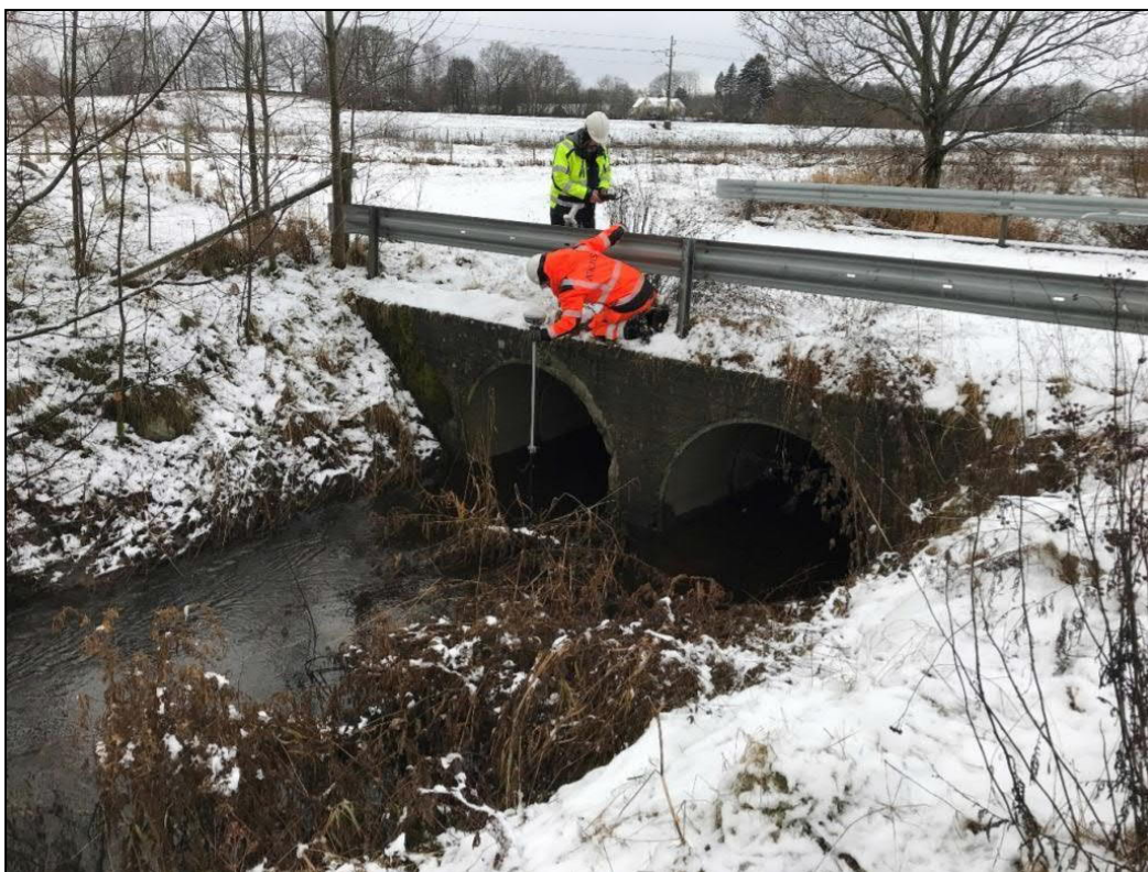
Figur 5. Befintlig enskild väg över Fjälövsån. Ån leds genom två 1700 mm trummor under den enskilda vägen som ligger 25 meter väster om den planerade passagen av väg 2023. Foto: Atkins
