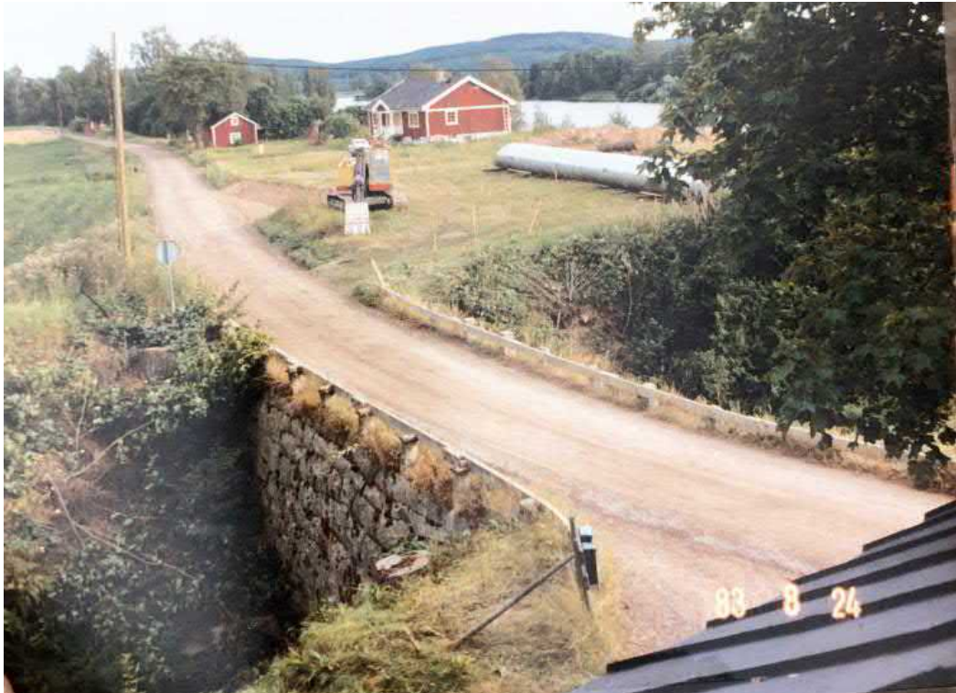
Figur 17. Vägmiljön vid Brogård år 1983 innan borttagande av stenvalvsbro och breddning av väg 751.
