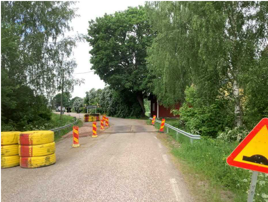
Figur 16. Vägmiljön vid Brogård, väster om Duvåker inför byte av vägtrumma år 2021.
