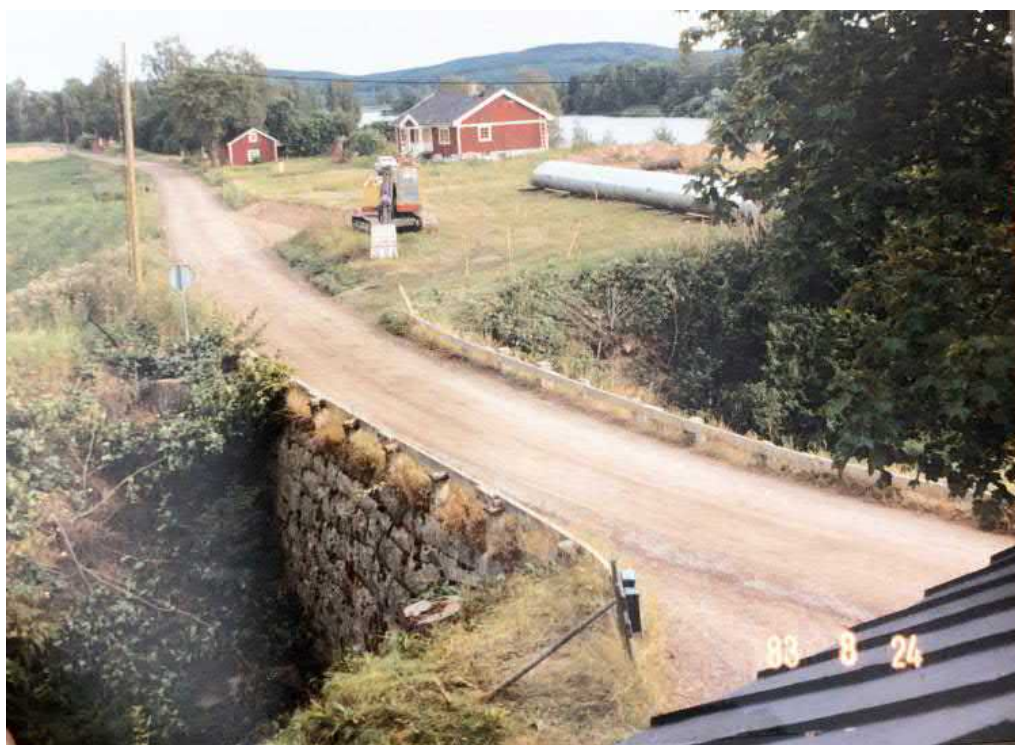
Figur 15. Vägmiljön vid Brogård, väster om Duvåker, år 1983 omedelbart innan borttagande av stenvalvsbro och breddning av väg 751.
