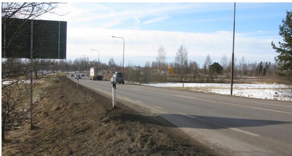
Figur 2.4.4.2. Väg 23 är en landsväg utan gångbana som ligger skild från bebyggelsen. Bilden visar väg 23 vid Målilla mot söder. Buskridån som delar den öppna gräsmarken väster om vägen syns ungefär mitt i bilden.
