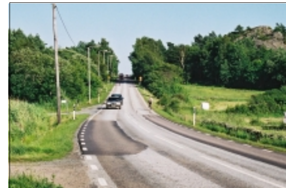
Otillräcklig vägbredd samt avsaknad av cykelbana är några av bristerna med befintlig väg.
