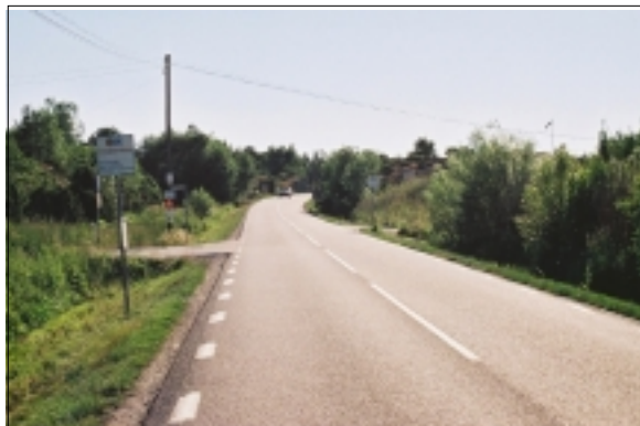
Busshållplats vid Toftbergsvägen. Tjuvkil är välförsörjt med kollektivtrafik, men flera busshållplatser saknar ficka
