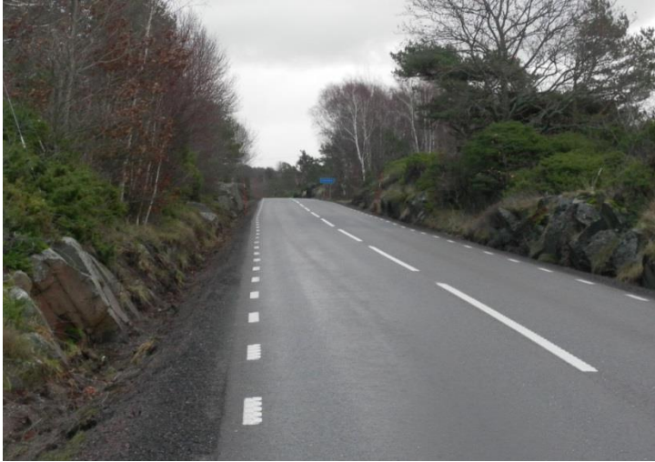
Figur 4 Väg 168 går genom bergskärningar där berget ligger nära vägen.
