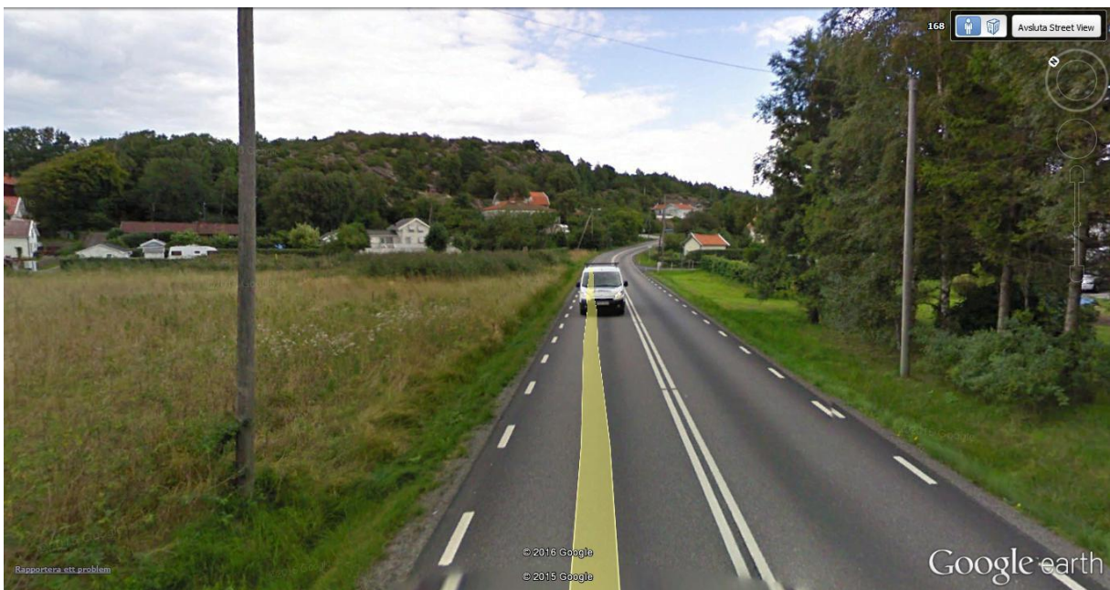
Figur 17 Avsaknad av vägren, räcken, svängfält, refuger, busshållplatser och separat gång- och cykeväg bidrar till känslan av att vara på landet. Bilden är tagen österut mot Tjuvkilskrysset. (Källa: Google Earth).
