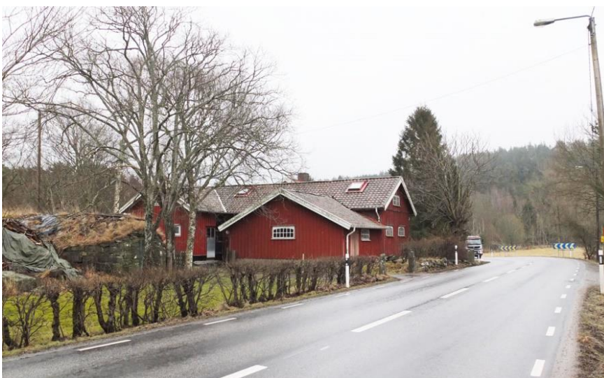
Figur 46 Äldre bebyggelse i anslutning till vägen med stengärdesgård, grindstolpar och jordkällare.
