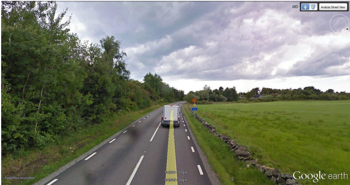
Figur 16 Väg 168 är en småskalig, enkel landsväg som understryker landskapets formelement genom placering och avsaknad av moderna attribut. Vägen här sedd från en punkt väster om Tjuvkilskrysset (korsningen mellan väg 168 och väg 612). (Källa: Google Earth).
