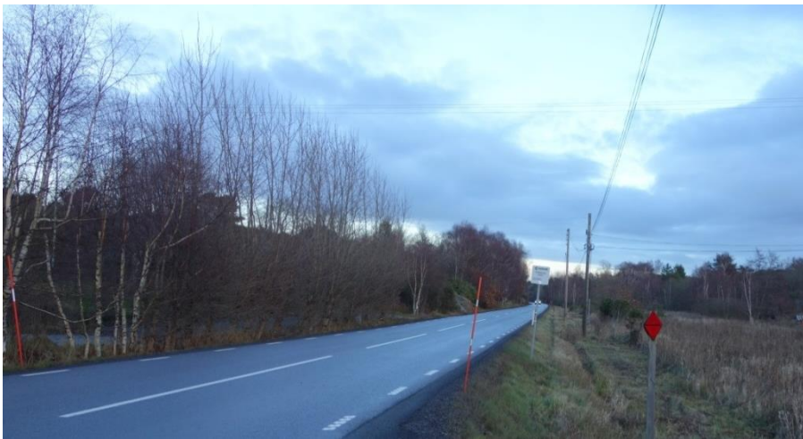
Figur 3 Befintlig väg saknar vägren samt gång- och cykelväg. Busshållplatser saknar ståtor för väntande resenärer.
