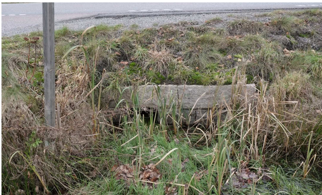
Figur 20 Bäck A i kulvertering under väg 168.
