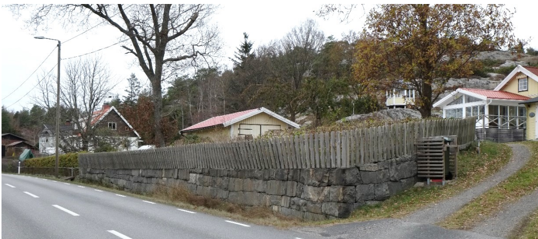
Figur 14 Terrasseringsmur av bearbetad gråsten
