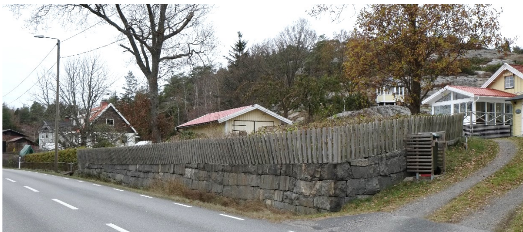
Figur 15 Terrasseringsmur av bearbetad gråsten.
