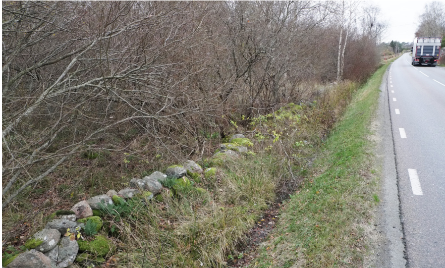
Figur 21 Stenmur invid dike med bakomvarande vegetationsridå.
