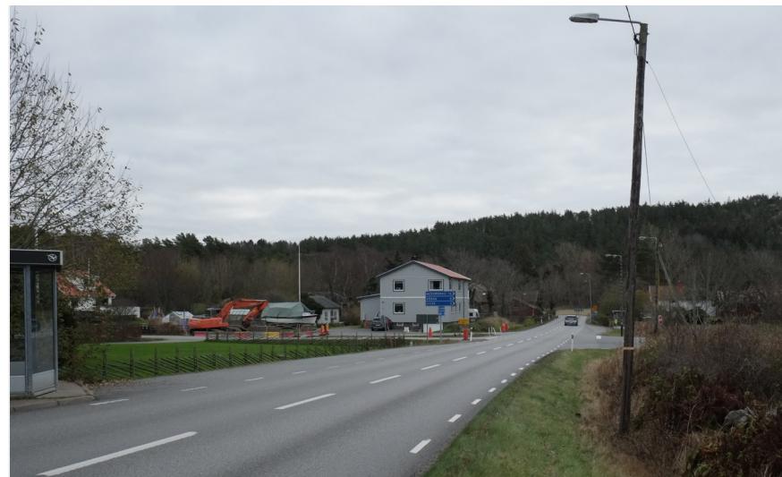
Figur 15 Befintliga belysningsstolpar är av trä med föråldrade armaturer och luftledningar.
