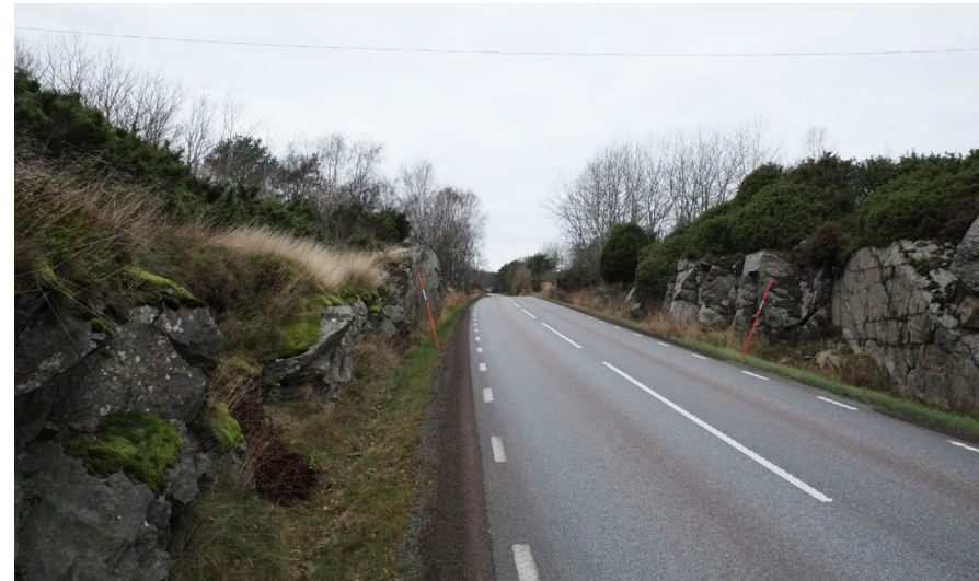
Figur 16 Äldre bergsskärning på båda sidor om vägen vid ca km 0/600.
