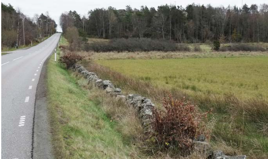
Figur 9 Stenmur mellan vägslänt och åkermark.
