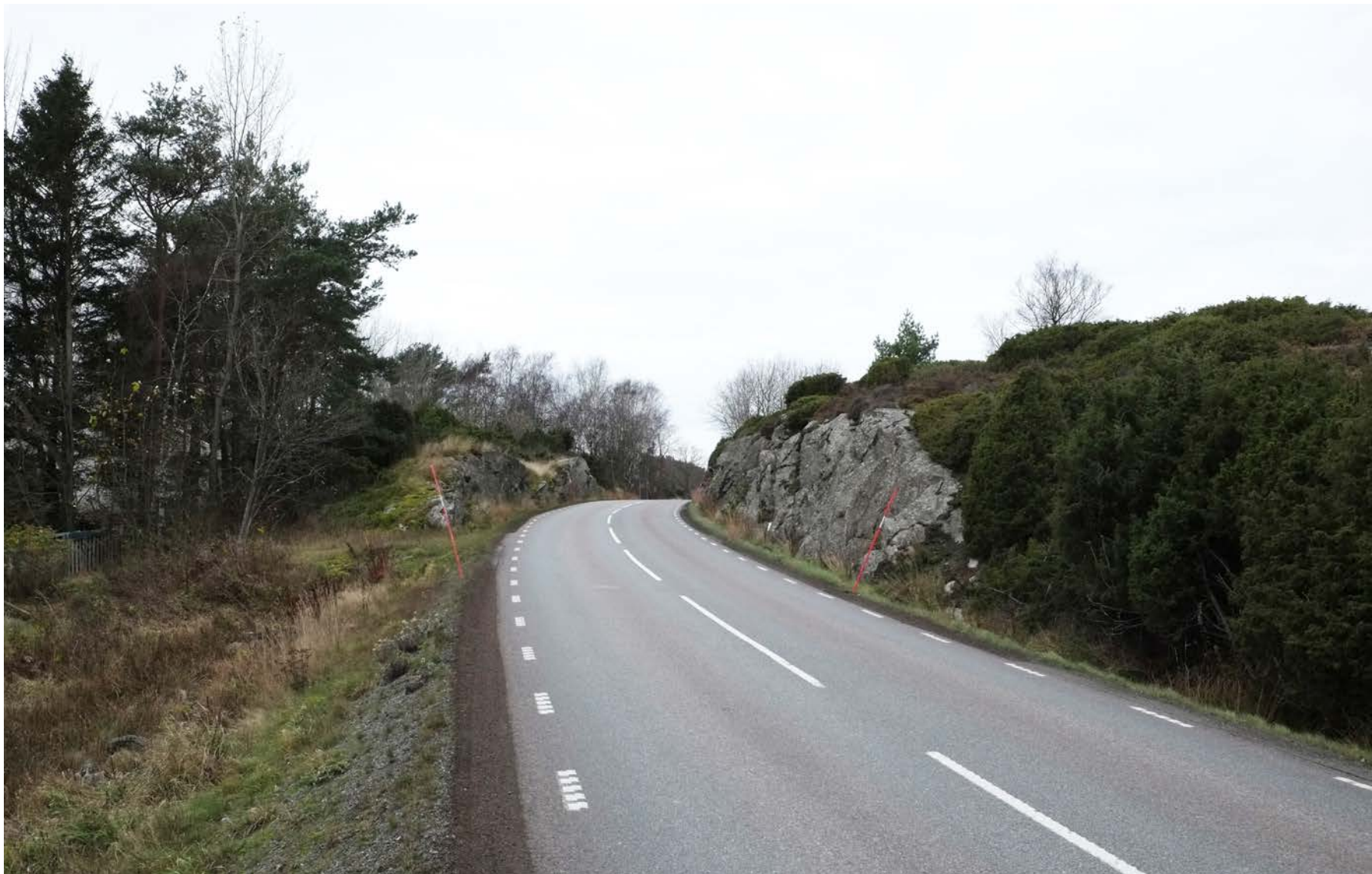
Figur 1 Väg 168 ca km 0/600.
