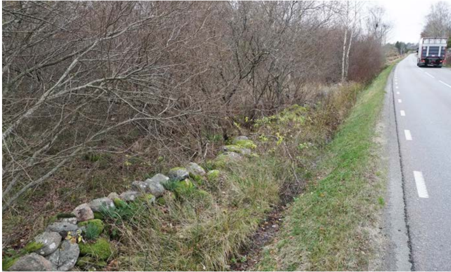
Figur 21 Stenmur invid dike med bakomvarande vegetationsridå.
