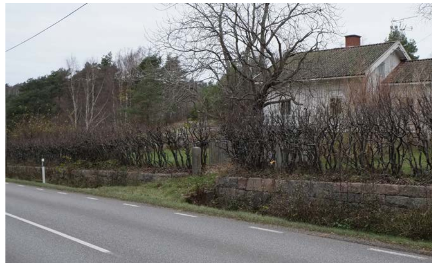
Figur 28 Stenmur vid Tjuvkil 5:1.
