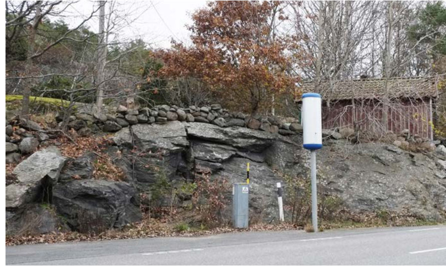
Figur 22 Stenmur på berg.
