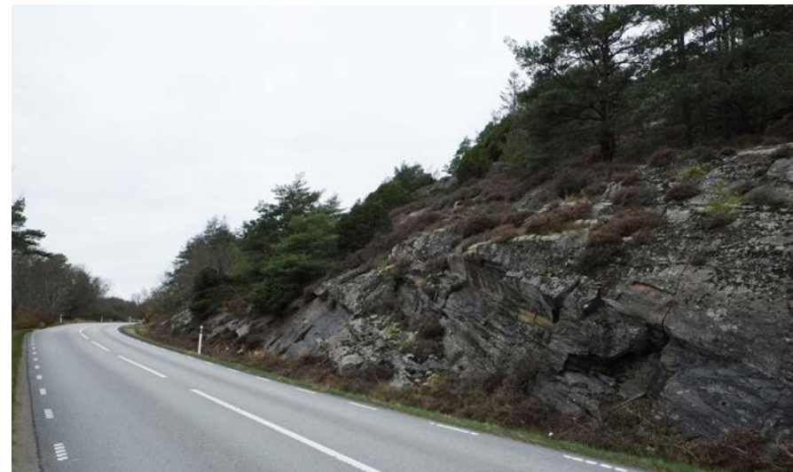
Figur 17 Äldre bergsskärning norr om vägen vid ca km 3/300.
