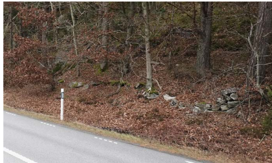
Figur 24 Stenmur i sluttning med trädvegetation.
