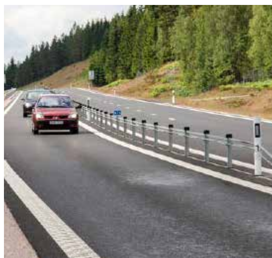
Figur 4.5 Vajerräcken är mindre påtagliga i landskapet än exempelvis w-profil räcken och ger ett mjukare intryck i vägrummet. Foto: ATA
