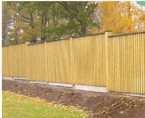
Figur 4.7 Bullerplank med trappning. Foto: Skandinaviska områdesskydd.
