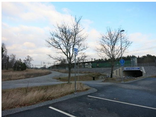
Figur 17: Rosersberg pendeltågstation, västra utgången
