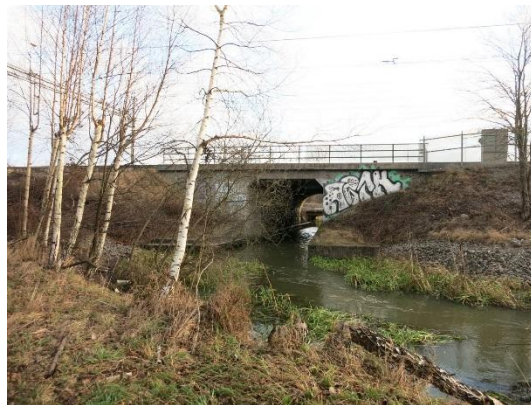
Figur 11: Verkaån passage under järnväg, västra sidan om bron
