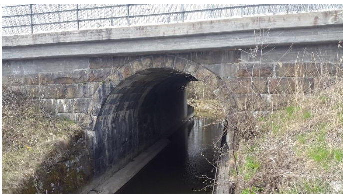
Figur 16: Stenvalvsbro Verkaåns passage under järnvägen
