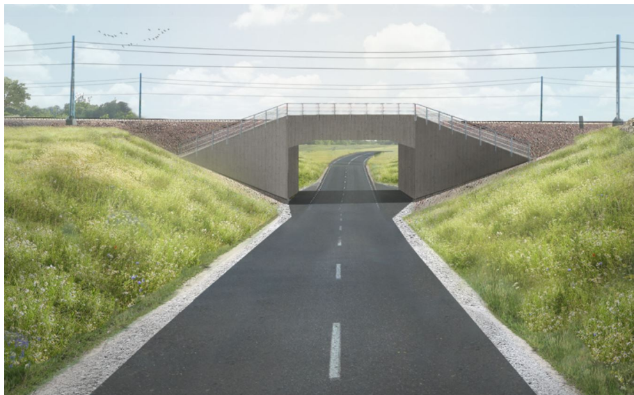
Figur 10 Föreslagen ny järnvägsbro i Attarp, sett söderifrån på ny väg 2023. Erosionsskydd, i form av krossad sten, kommer att täcka delar av slänterna.
