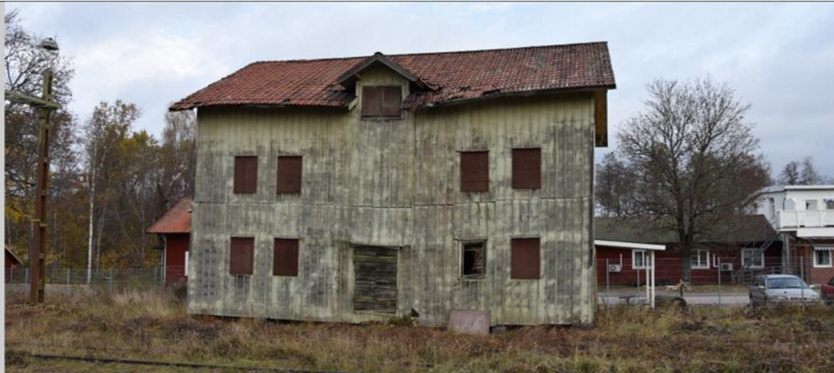
Figur 10. Det gröna kolhuset/godsmagasinet/södra fasad.
