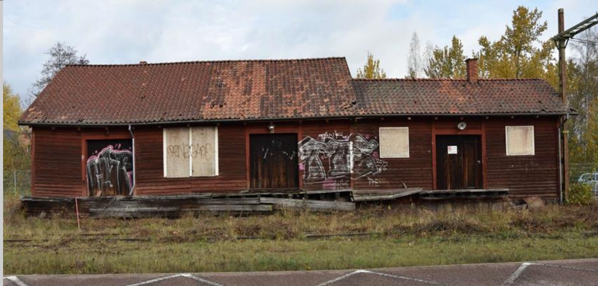
Figur 9. Det röda godsmagasinet/södra fasad med raserad lastbrygga av trä synlig.
