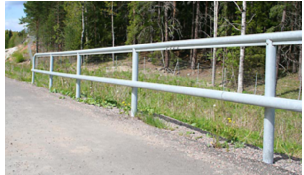
Figur 4. Exempel på en enkel typ av gång- och cykelräcke som inte gör allt för stort visuellt intrång i landskapet.
