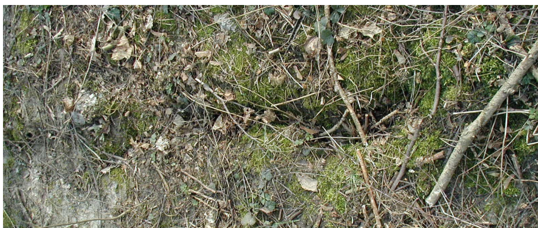
Figur 3 Spricka i slänten mellan GC-väg och Sävån (i anslutning till borrhål 1). Observationstillfälle februari 2002.
