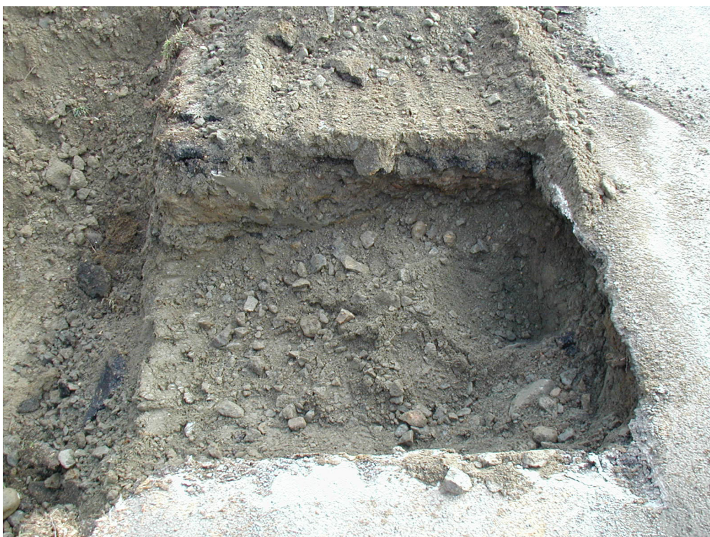
Överbyggnadsmaterial i GC-vägen vid provgrop E.
