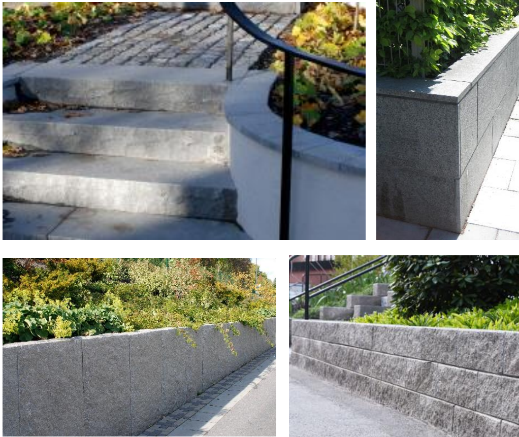
Figur 8. Exempel på trappor och murar i natursten samt räcken och handledare i målat stål.
