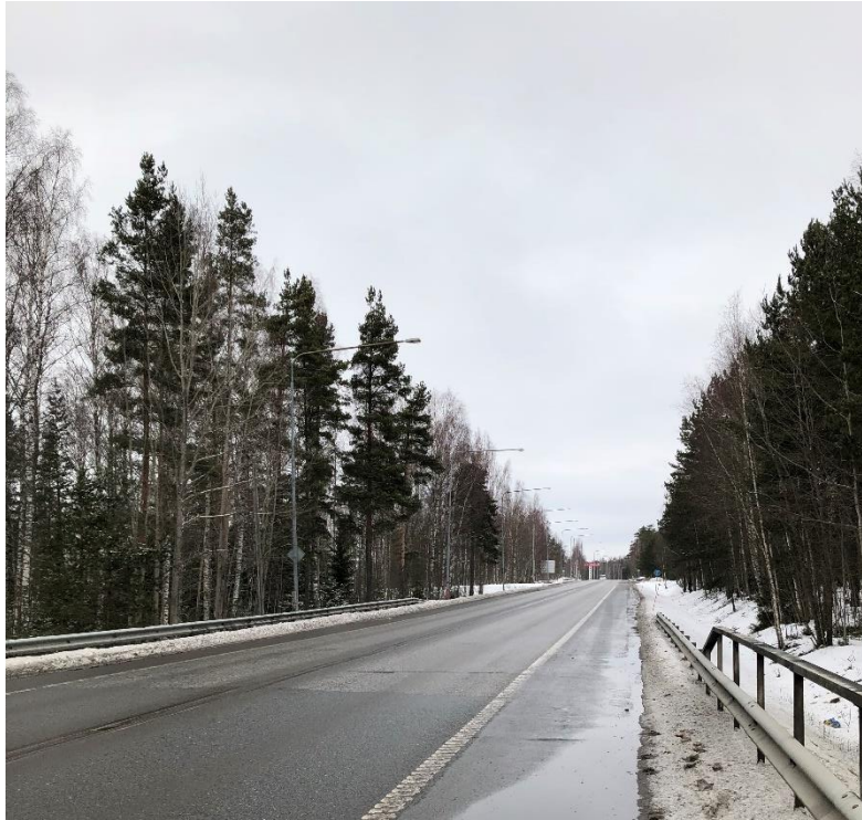
Figur 21: Utblick söderifrån ovanpå vägbron, ett slutet vägrum strax norr om vägbron över befintlig väg 51.
