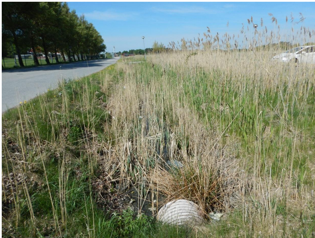
Utlopp i Berga-Törnby markavvattningsföretag.
