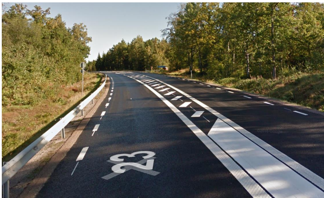
Figur 26. Otillräcklig horisontalradie förbi korsning med väg 693 mot Vederslöv medför kurvratning.
