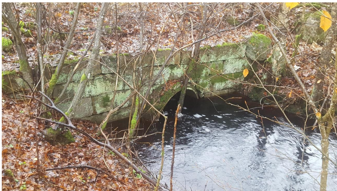
Figur 23. Brons västra sida. Förlängd i senare tid med en betongtrumma med diametern 1400 mm.
