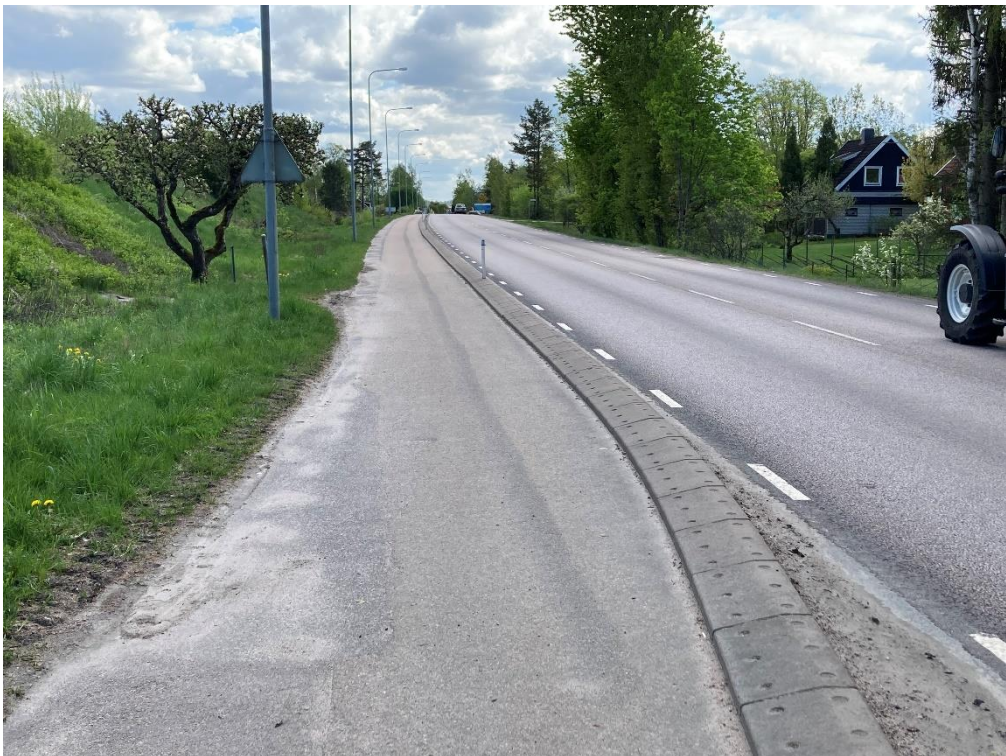
Figur 26. Exempelbild över utformning av vägnära gång- och cykelväg med GCM-stöd. Foto: Sweco.
