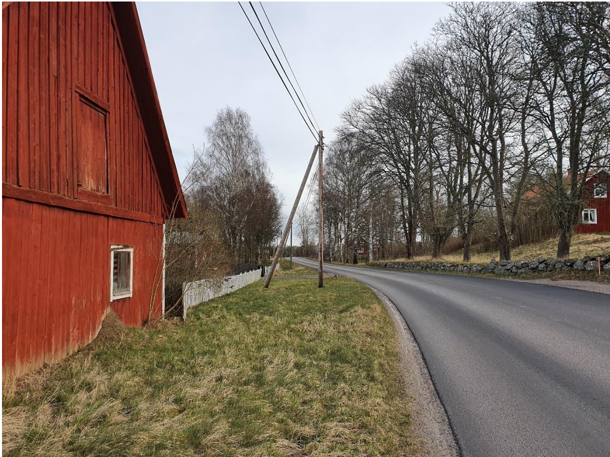
Figur 14. Hölminge bytomt (L1955:9536) från söder. Till höger i bild syns trädgårdsmuren. Foto Sweco 2020.
