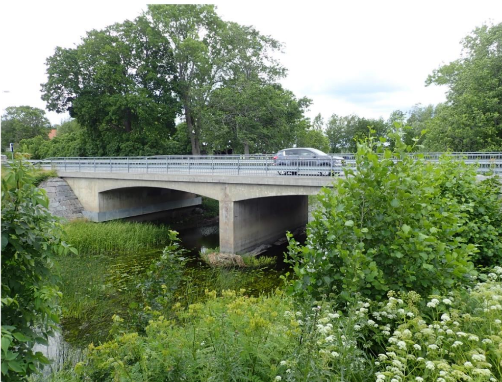
Figur 15 visar befintligt byggnadsverk, som är en vägbro i Hökhuvud (BaTMan Bridge & Tunnel Management).
