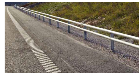
Figur 24 - Bilden visar ett rörräcke i vägmiljö. Källa: Vägbilder, Trafikverket
