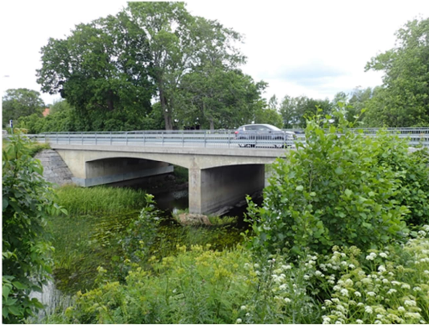
Figur 19. Befintlig vägbro i Hökhuvud (BaTMan Bridge & Tunnel Management).
