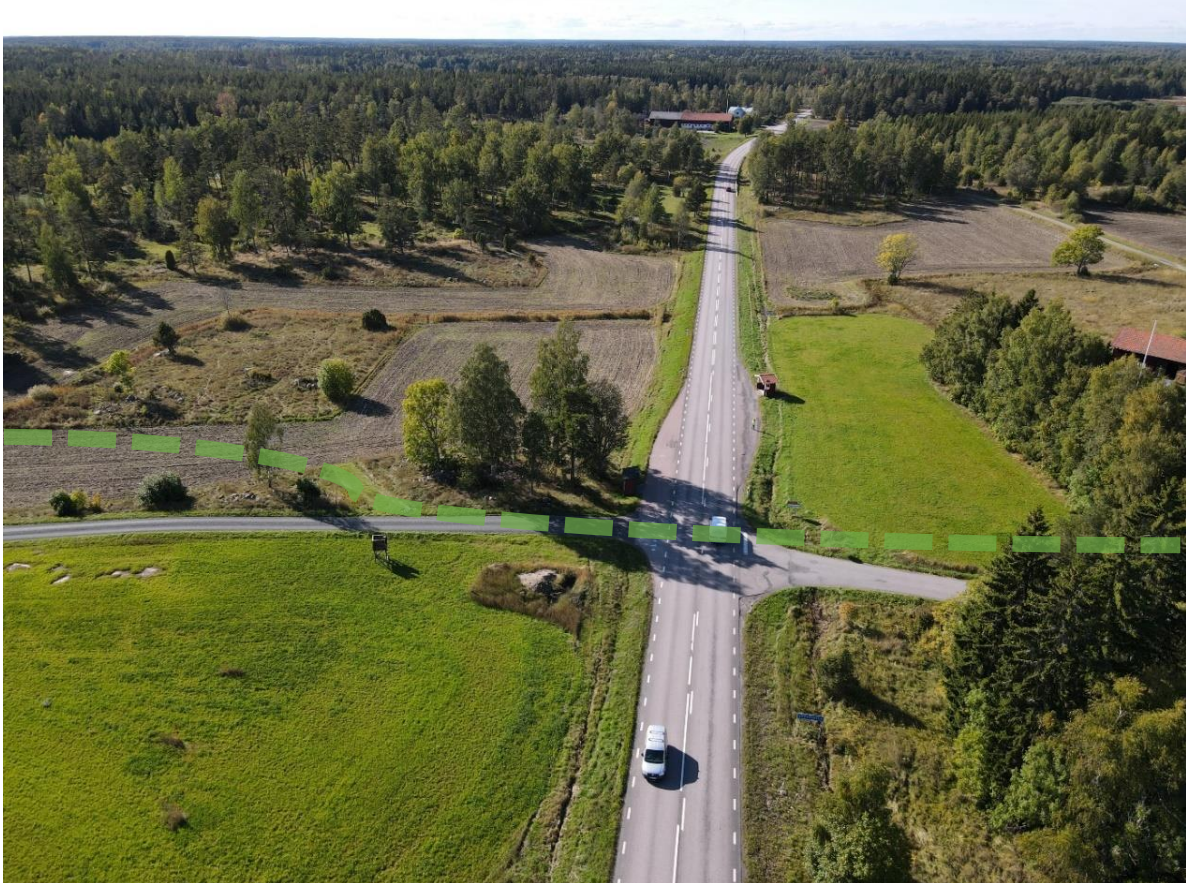
Figur 11. Plats för planerad planskild passage vid Uppskedika där befintlig utfart stängs. Ungefärlig sträckning av vägport är markerat med grön streckad linje (---). Vy mot väster.
