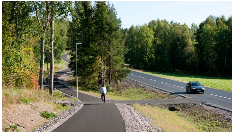
Bild 20. Ligger mindre vägar nära väg 49 förläggs de i samma sektioner men finns motiv kan linjeföringen för den mindre vägen avvika från huvudvägens. Foto: Trafikverket, 2012.
