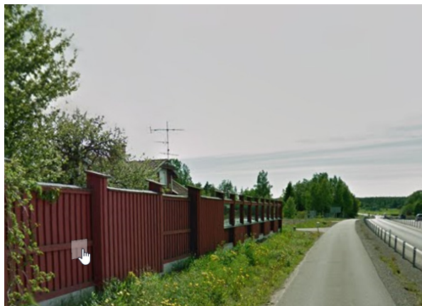
Bild 24. Bullerskyddsåtgärder föreslås likt ovan men i grön slamfärg. Foto: Google maps, 2019-10-21.
