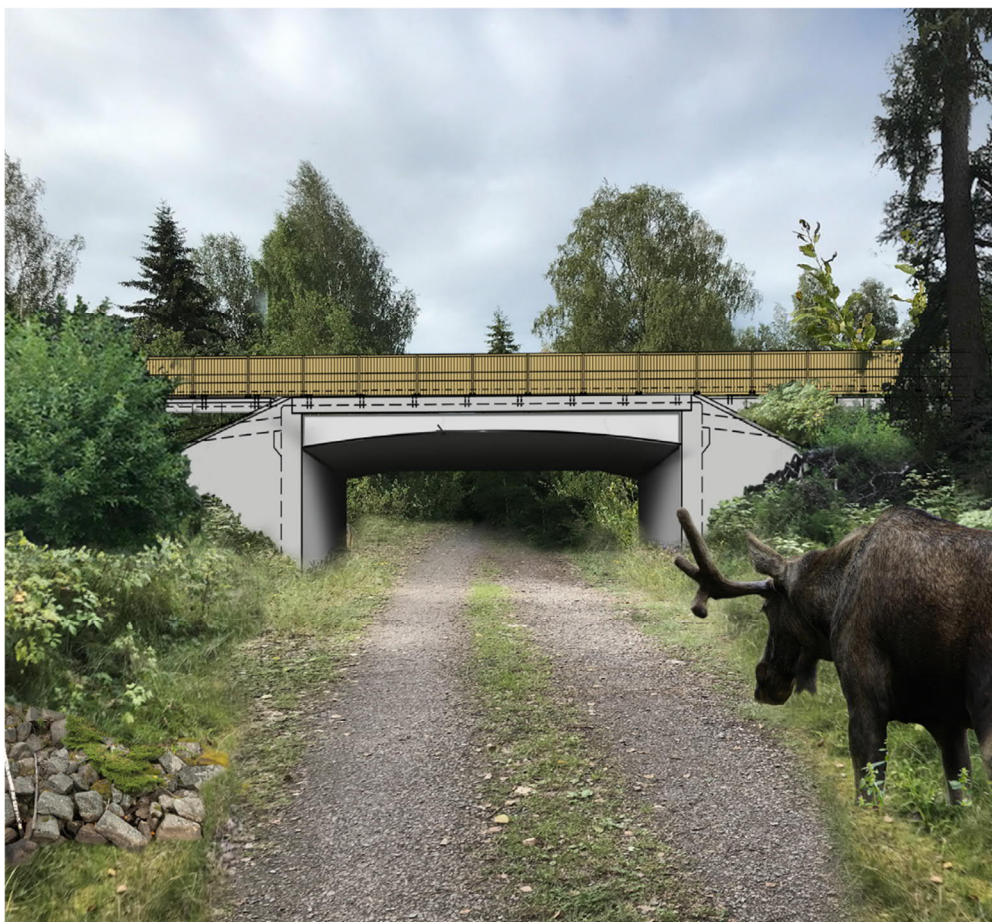
Figur 44. Fotomontage av faunaporten under väg 49. Av: Hanna Lange, Sweco Sverige AB. Bilder hämtade från https://www.maxpixel.net/Sweden-Male-Bull-Moose-Moose-Antler-Animal-901880 .
