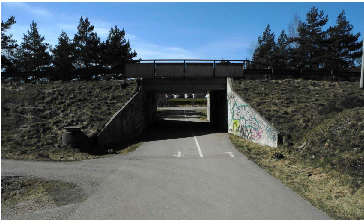
Figur 12. Gångtunneln under Österleden som förbinder Fylleryds Naturreservat med området vid Fagrabäckskolan.
