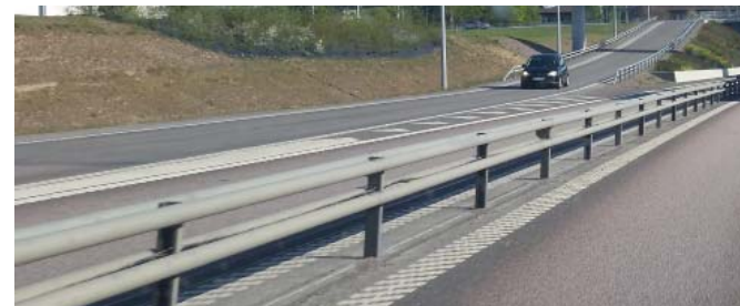
Figur 83. Bild som visar rörräcke i trafikmiljö.
