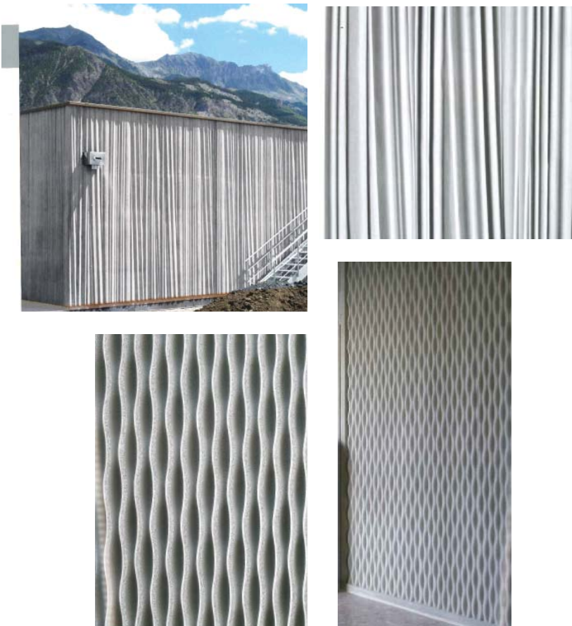
Figur 69. Exempel på murar med olika mönster i strukturbetong.
