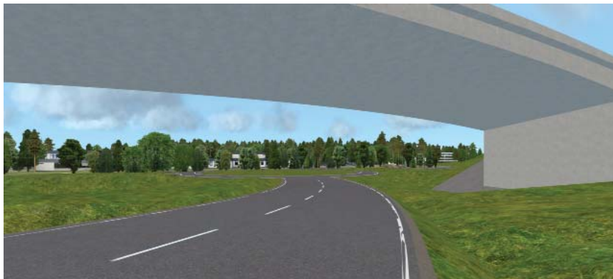
Figur 60. Bild ur vägmodell som visar den norra porten under väg 27 med den nordvästra cirkulationsplatsen i bakgrunden.
