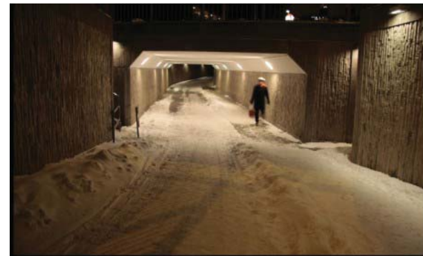
Figur 70. Exempel på strukturbetong i GC-port.
