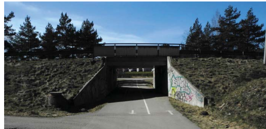
Figur 11. Gångport under Österleden som förbinder Fylleryds Naturreservat med området vid Fagrabäckskolan.
