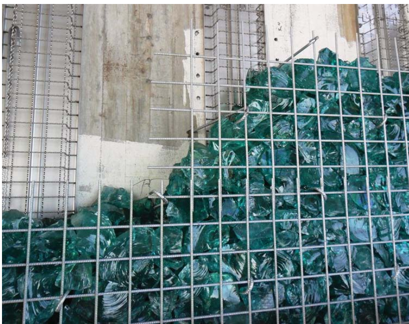
Figur 62. Exempel från Kista som visar glasgabion under uppbyggnad.
