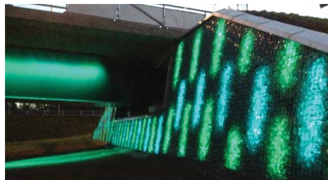
Figur 63. Glasgabion som belyses nattetid.
