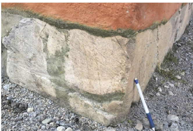
Figur 7. De flesta grundstenar av sur vulkanit förefaller obearbetade men enstaka (t.ex. denna hörnsten på en strävpelare från norra långsidan) är välhuggna.
