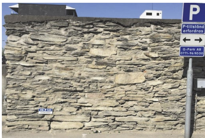
Figur 9. Mur nära N. Järnvägsgratan vid Växjö resecentrum (kvarteret Håkan Sjögren). De flesta stenar består av sur vulkanit, sannolikt av lokalt ursprung. Muren antas ha tillkommit mellan 1875 och 1918.
