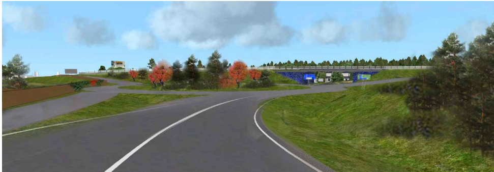
Figur 24: Vy från väg 25 mot väg 27. Vegetation i cirkulationsplatsen samt utmed banken tonar ned denna.
